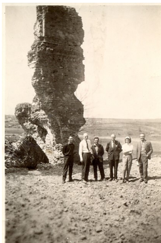
Fig. 3. Cătălui Turn clopotnița, 1965. Cătălui Turn campanile, 1965.
