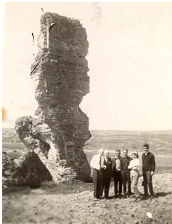
Fig. 4. Cătălui Turn clopotnița, 1965. Cătălui Turn campanile, 1965.
