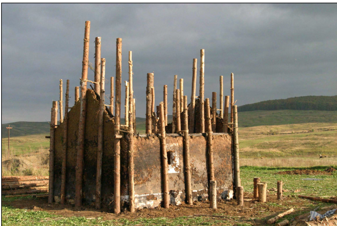
Foto 10. Reconstrucția „casei nordului” după ardere. Zvoriștea 2008. Reconstruction of “the house of Noth”. Zvoriștea 2008.
